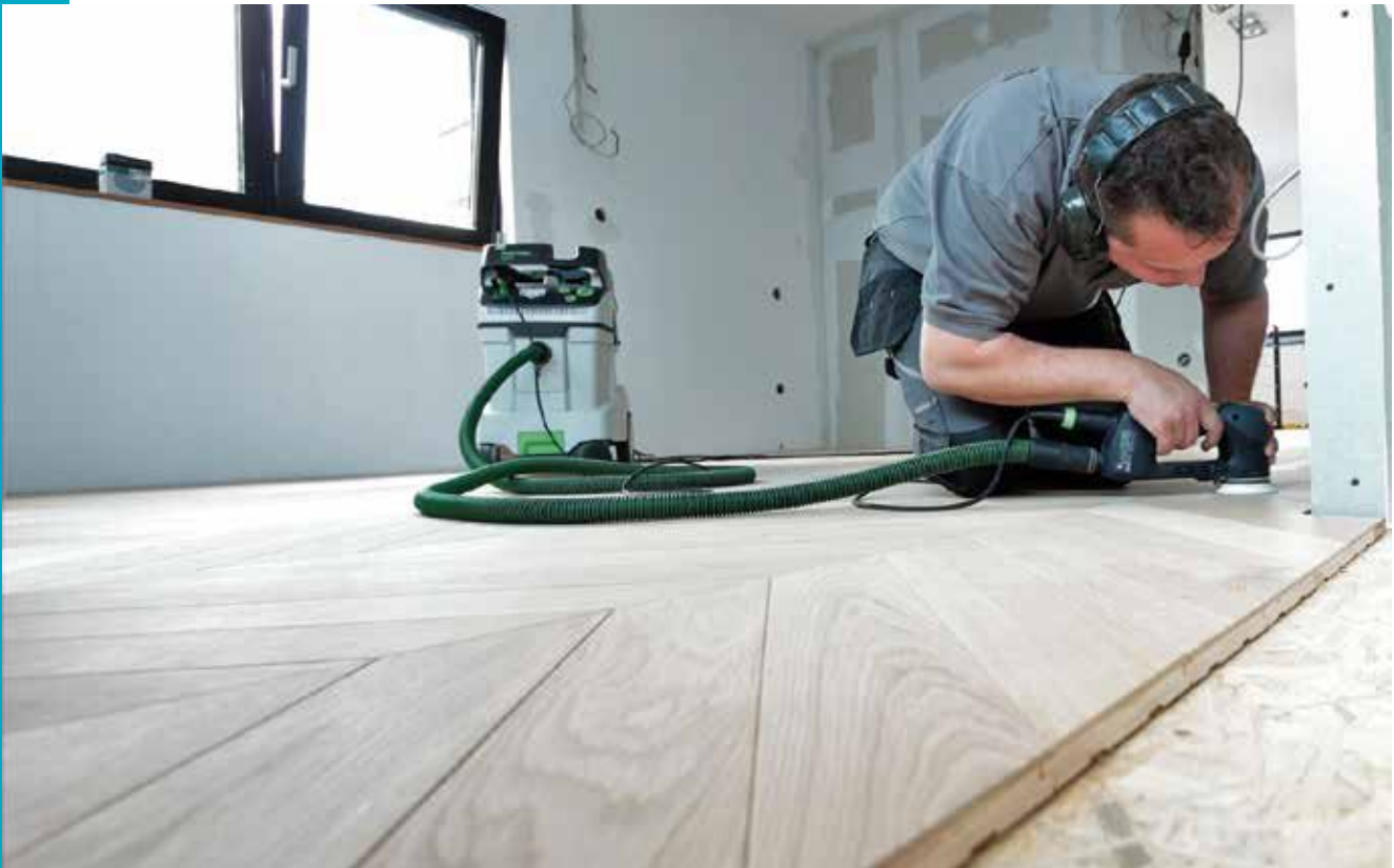
Áttételes hajtású excenteres csiszológép munka közben
