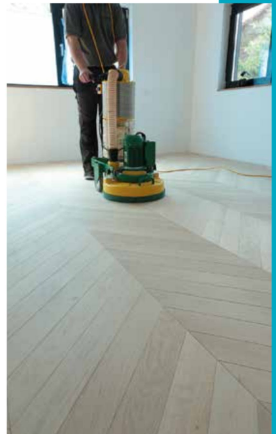
Háromtárcsás csiszológép munka közben
